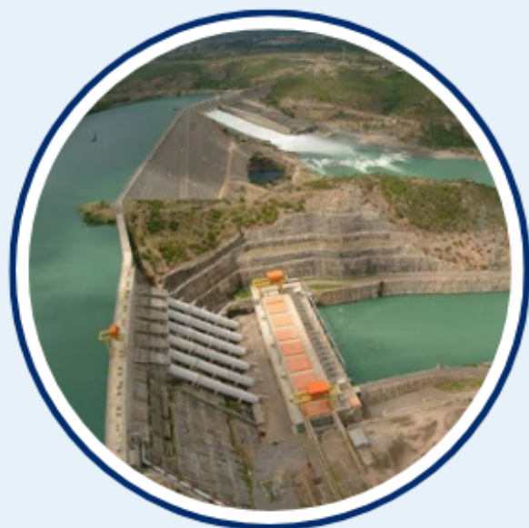
Usina Hidrelétrica de Xingó — Foto: Chesf/Divulgação/Arquivo
